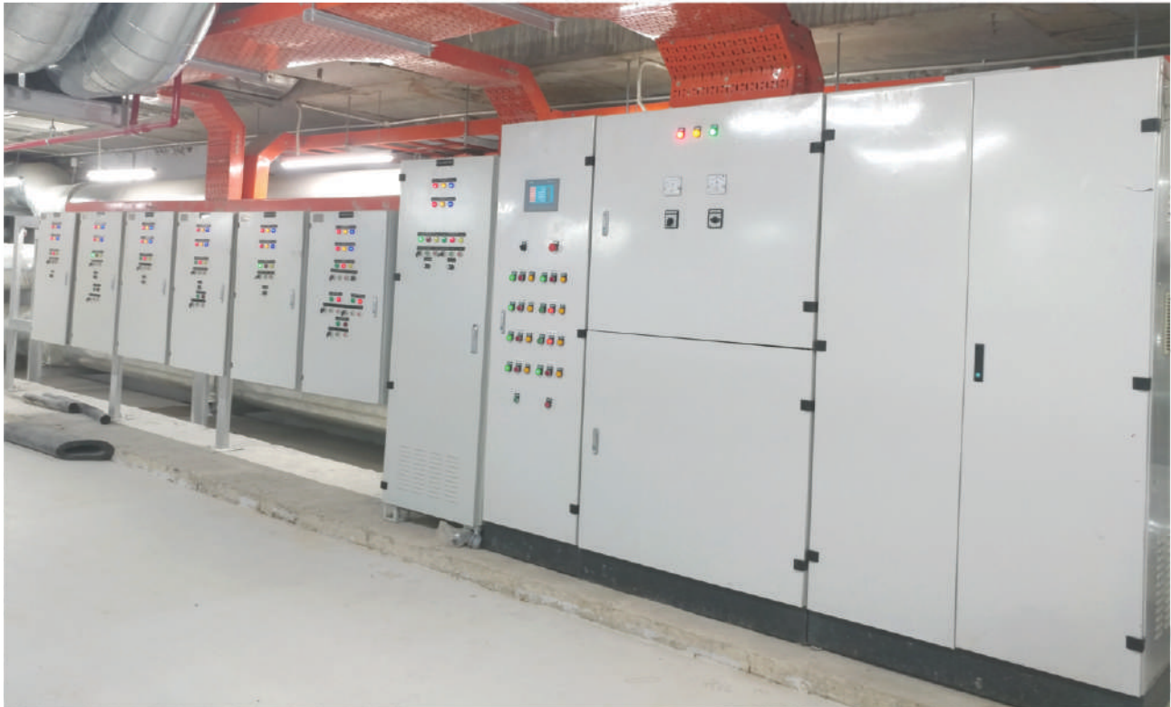
Dự án Sân trượt băng Vincom Ice Rink – Landmark 81/ Vincom Ice Rink Project – Landmark 81
