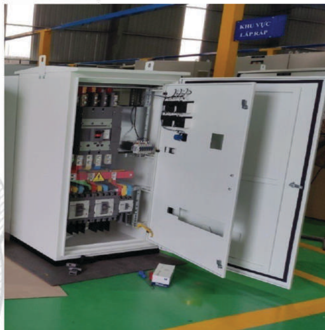
Dự án Trạm sạc tại Q.9 (TP. HCM) Charging Station Project in District 9 (HCM)
